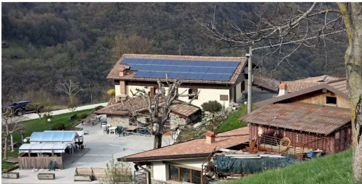
Vista da ovest della struttura
