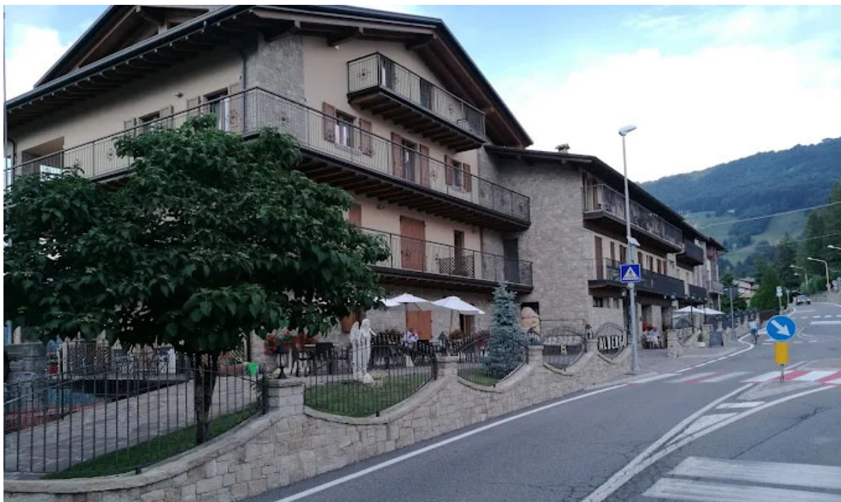
Vista da ovest della struttura
