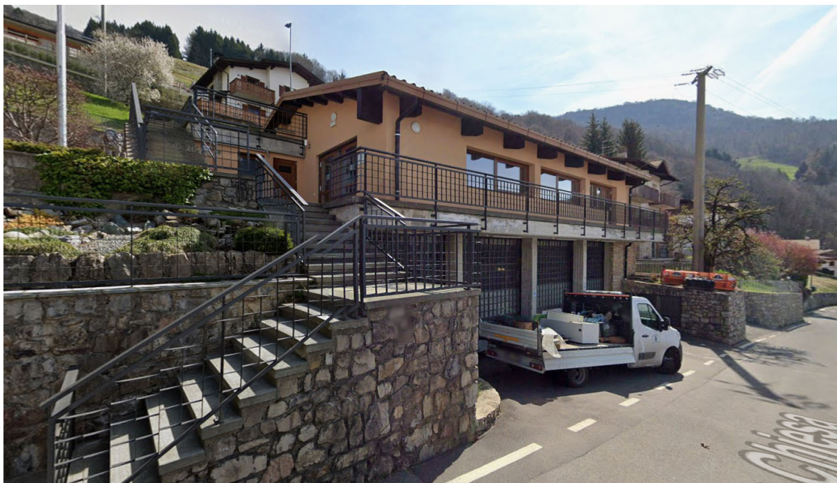
Vista da Via Chiesa della struttura
