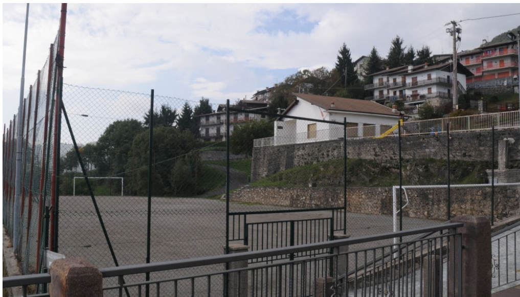
Vista della struttura dal sagrato della chiesa
