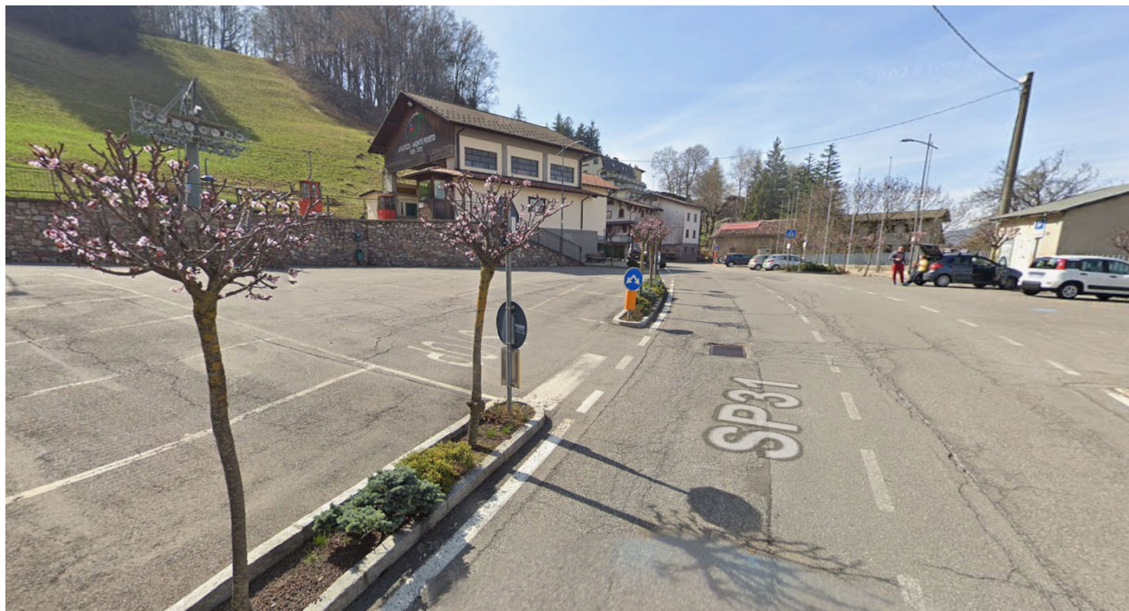
Vista da nord del piazzale da Via Cantul
